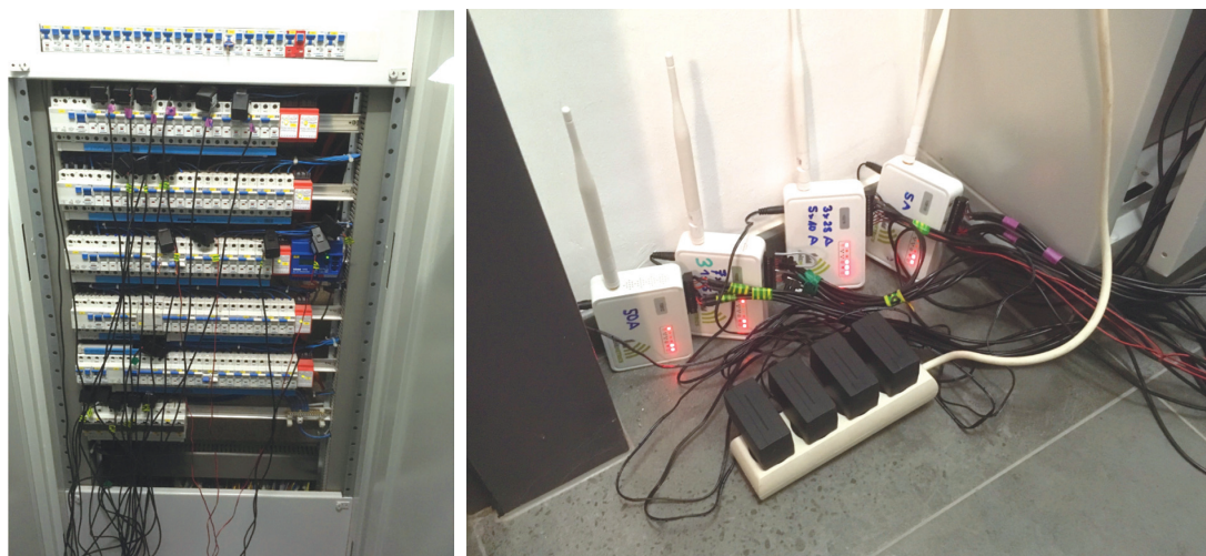
Detailmessungen wurden mit dem Messsystem von LineMetrics durchgeführt
